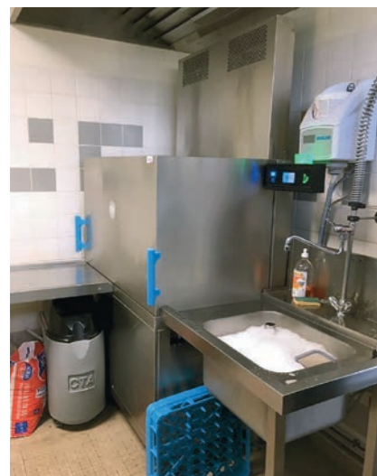
Cantine collective à Ensues-la-Redonne
